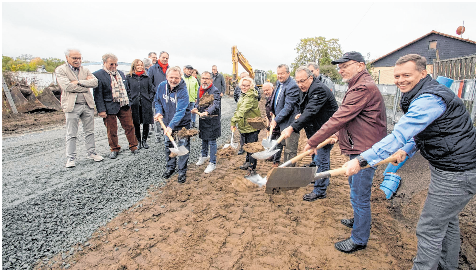
Spatenstich für das Gewerbegebiet Am langen Pfad: Ende des nächsten Jahres sollen im Gewerbepark die ersten Mieter einziehen.
