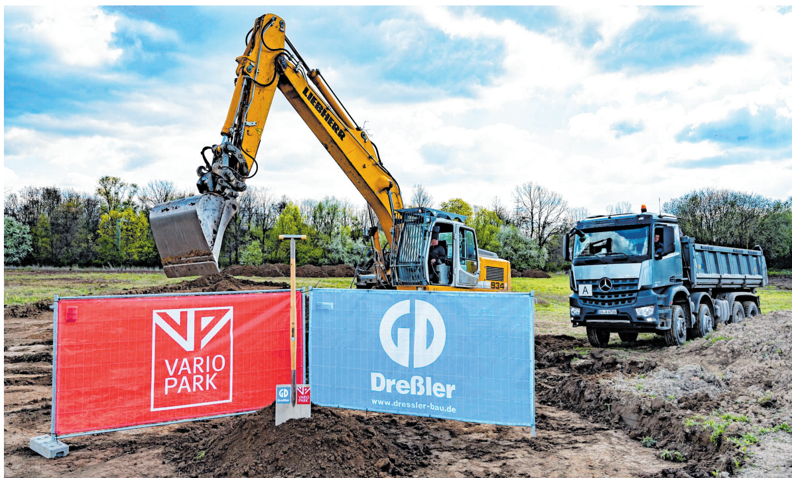
Spatenstich ganz ohne Publikum: Die Bauarbeiten für den Vario Park an der Bruchwiese haben begonnen.
