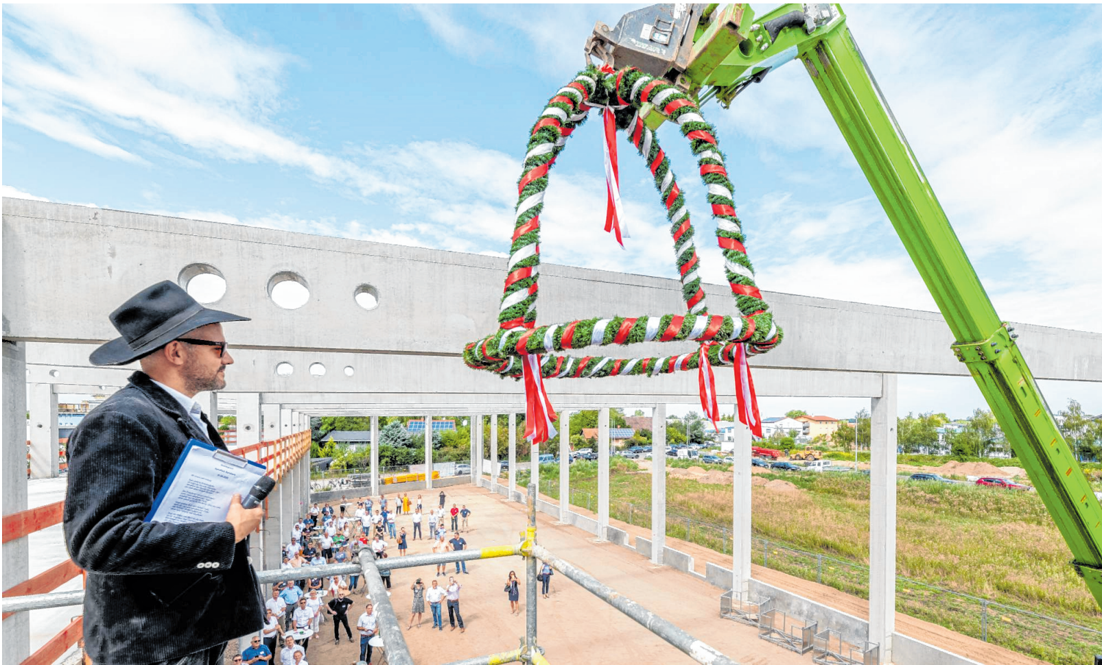
Der Kranz hängt: Maurice Kugel trug beim Richtfest des Vario Parks den traditionellen Richtspruch vor. Die Hallen sollen ab Mitte Dezember bezugsfertig sein.
